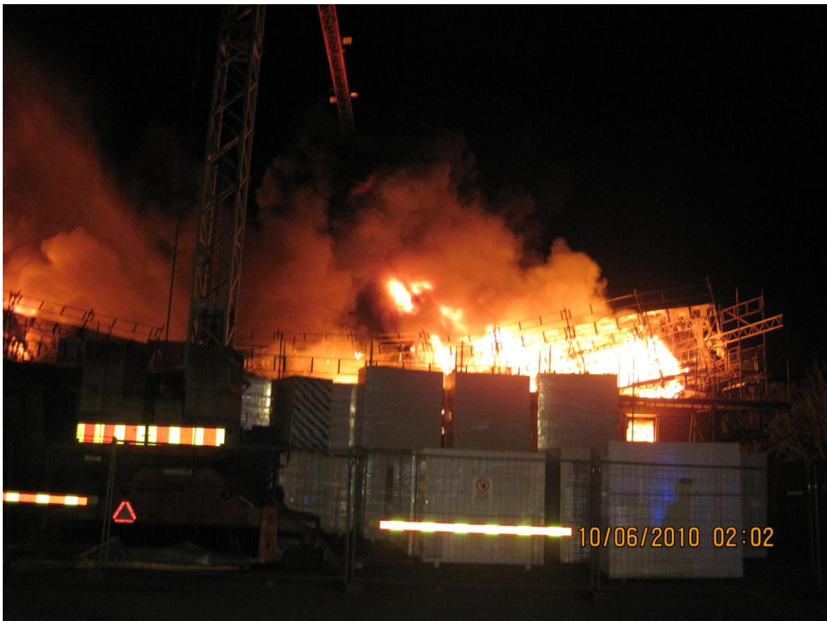
Bild 2. Takkonstruktionen kollapsar 30 minuter senare.
